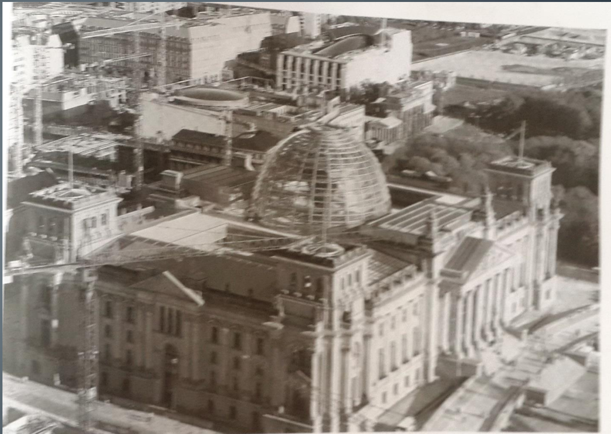
شماره ۱۱۰ - ساختمان پارلمان آلمان - رایشتاگ - در برلین - پس از احداث گنبد شیشه‌ای بر بالای آن
