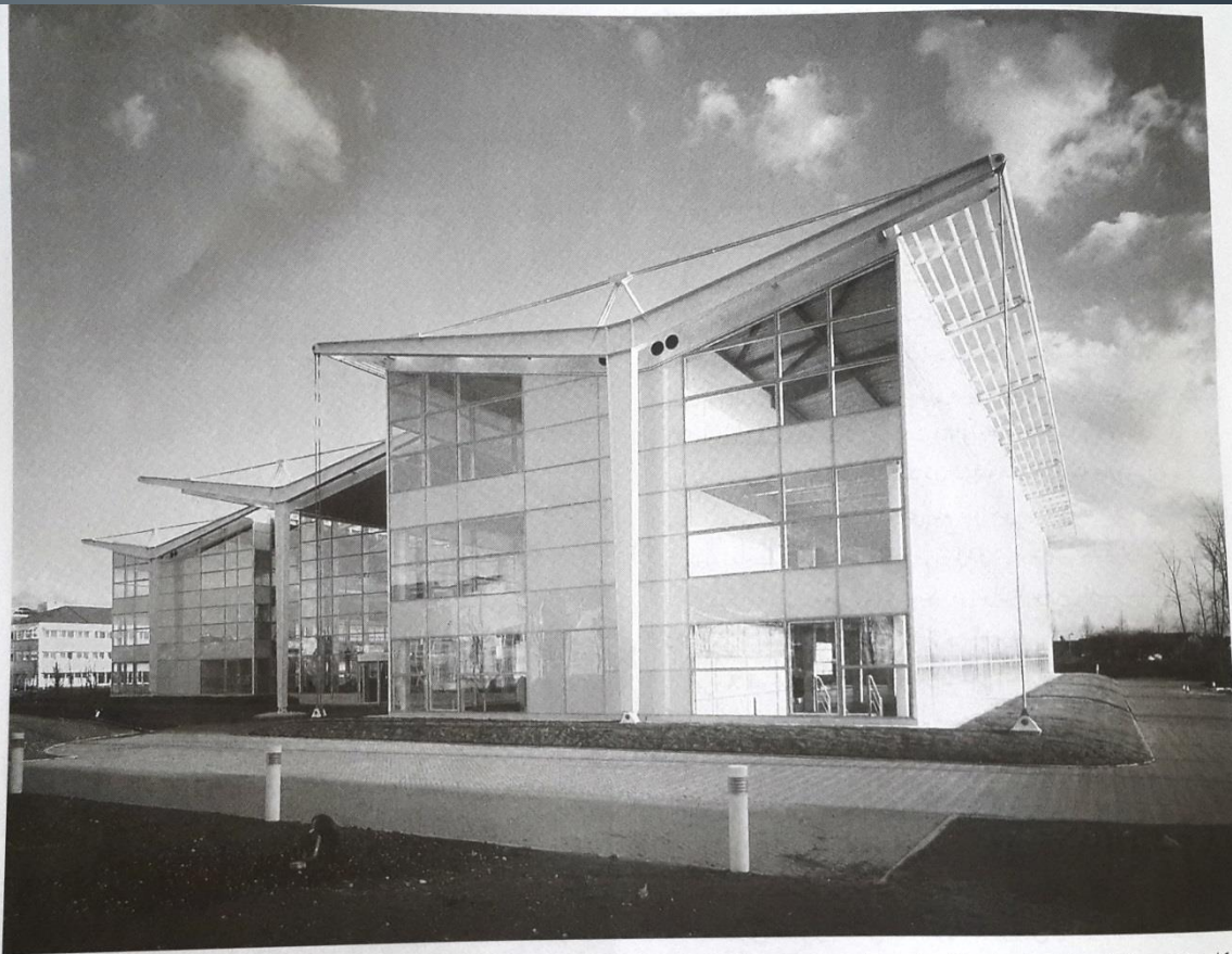
شکل ۳.۷ هیچ یک از عناصر و اجزاء به کار رفته در طرح‌های نورمن فاستر، تزئینی یا غیرعملکردی نیستند. در این ساختمان اداری سه طبقه در استنلی پارک لندن (۱۹۸۹)، سازه به شکل ۲، لولای زیر این سازه و کابل‌های اطراف آن برای ایجاد حالت میرایی در ساختمان و در نتیجه مقاومت بهتر در مقابل نیروهای جانبی مانند باد و زلزله است.
