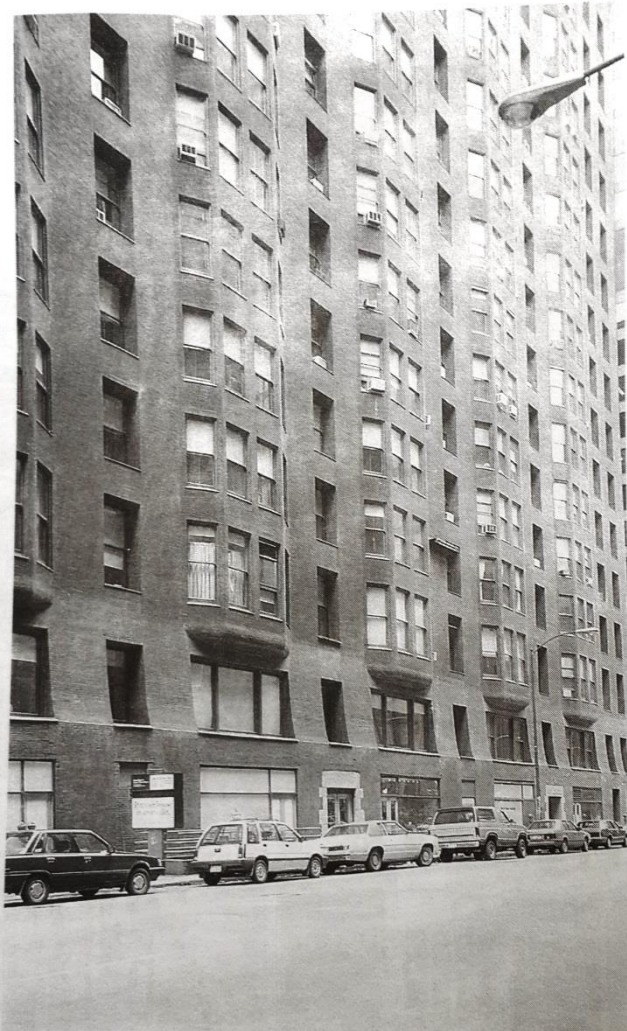
شکل ۲.۲. ساختمان شانزده طبقه موندناک در شهر شیکاگو ۱۸۹۱، طراحان برنهم و روت
