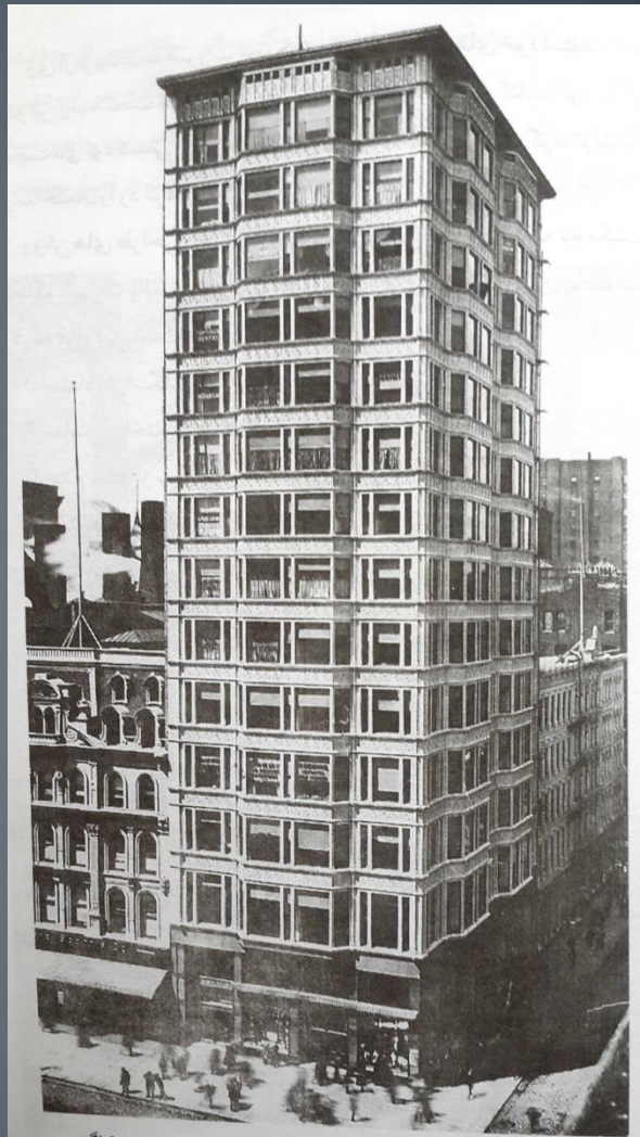
شکل ۶.۲ ساختمان شانزده طبقه ریلاینس با پنجره‌های سبک شیکاگو (۱۸۹۴-۱۸۹۵)، طراح برنهم و شرکا
